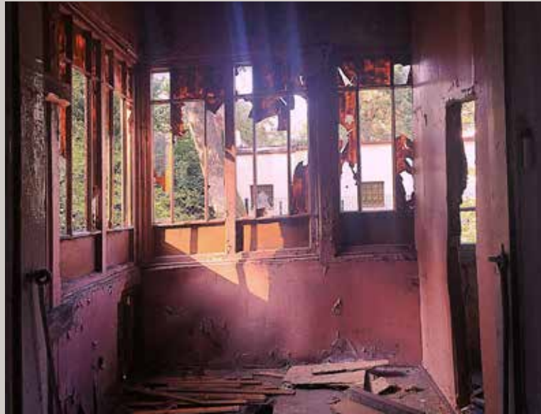
Wnętrze jednej z werand (dzięki uprzejmości portalu Rotten Inside Warsaw)
