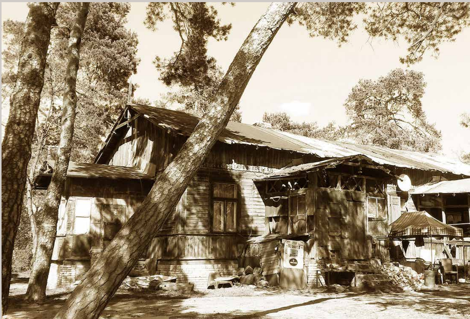
Dom przy ul. Panny Wodnej 30 – stan obecny, widok od strony południowej
