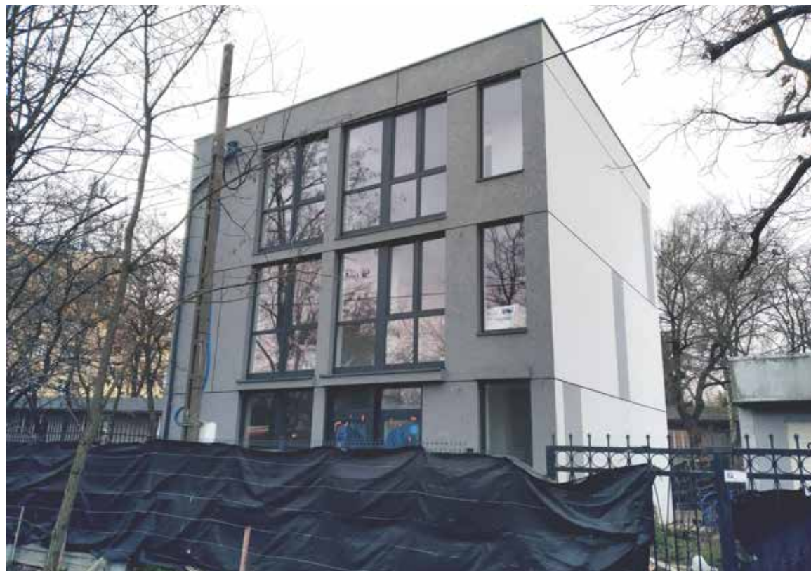
Budynek przy Lucerny 130
