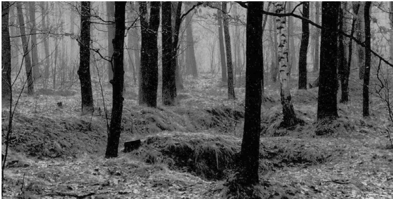
Pozostałości po okopach z 1944r. w lesie Branickich (ob. Las Wilanowski). Stan z 1998r. Fot. Wiktor Kulerski.
