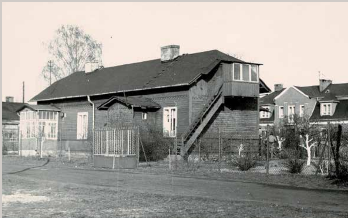
Tak wyglądał dom na Kożuchowskiej jeszcze w latach 70'. Fot. z archiwum W. Kulerskiego
