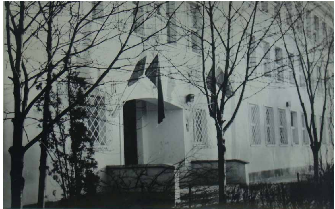
Główne wejście do SP 218 na ul. M. Kajki. Lata 80'. Fot. z archiwum A. Ciećwierza.
