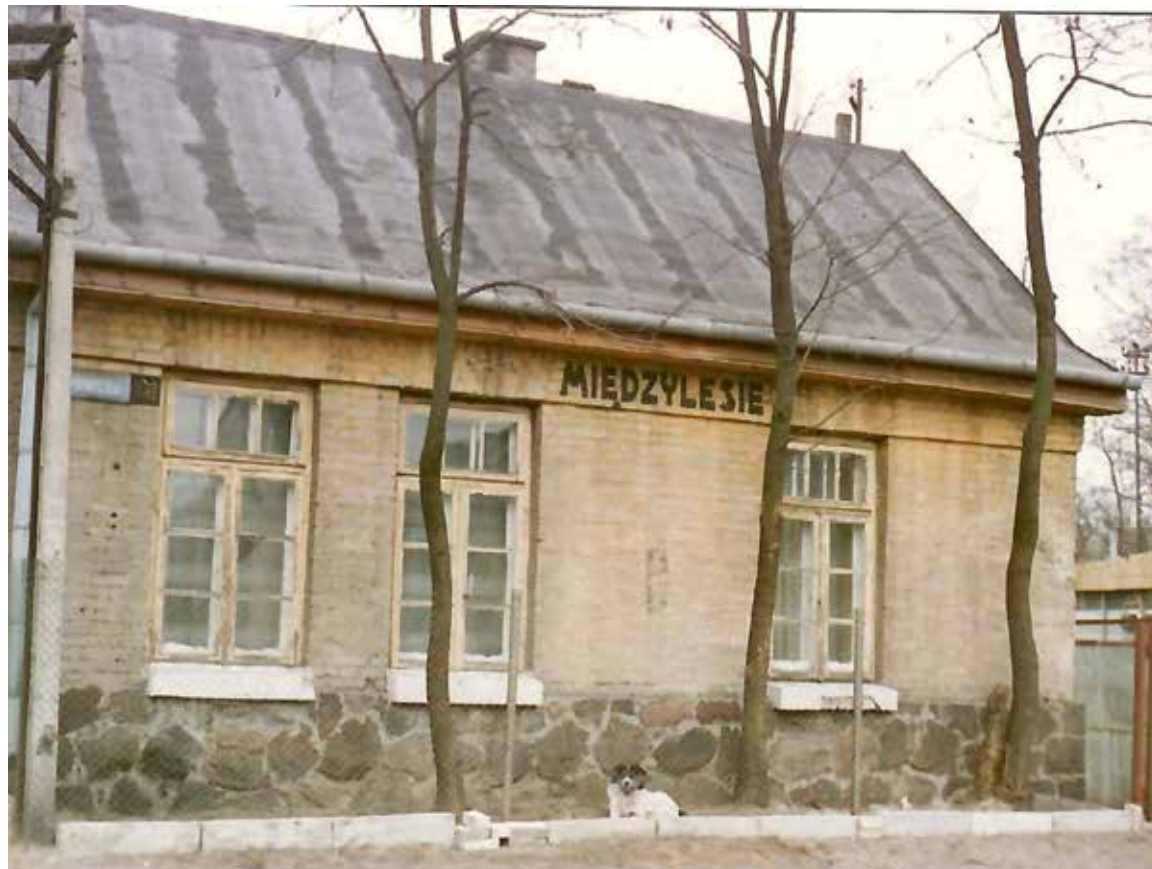
Budynek stacyjny ciuchci do Otwocka i Karczewa przy ul. Mrówczej. Koniec lat 80. XX w. Fot. Jerzy Zawistowski
