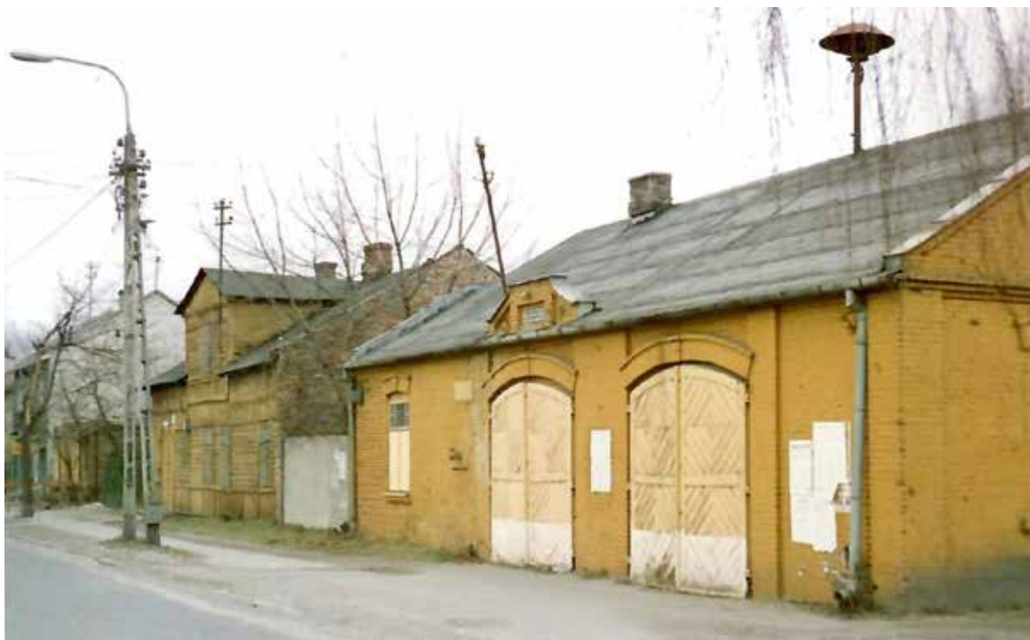
Dawny budynek straży ogniowej po północnej stronie ul. Żegańskiej. Koniec lat 80. XX w. Fot. Jerzy Zawistowski
