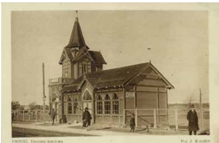
RADOŚĆ. Dworzec kolejowy.
